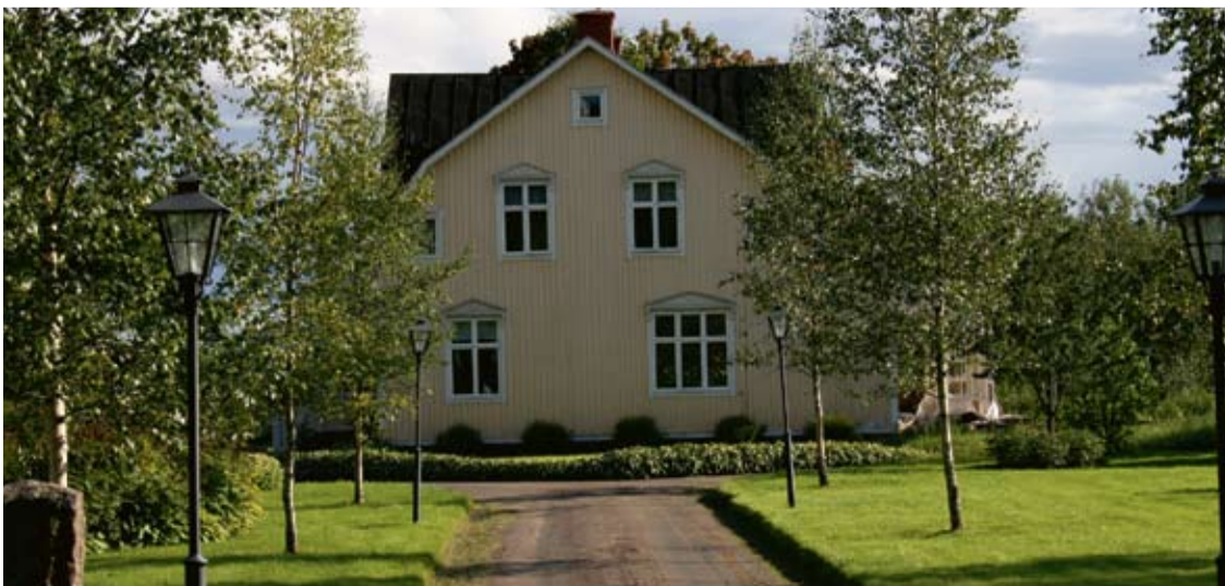
Lantidyll. Sussies 1920-talshus ligger vackert beläget i Stavik, inte långt från Mårbacka. Huset har varsamt renoverats under 16 års tid – en process som ännu pågår.
